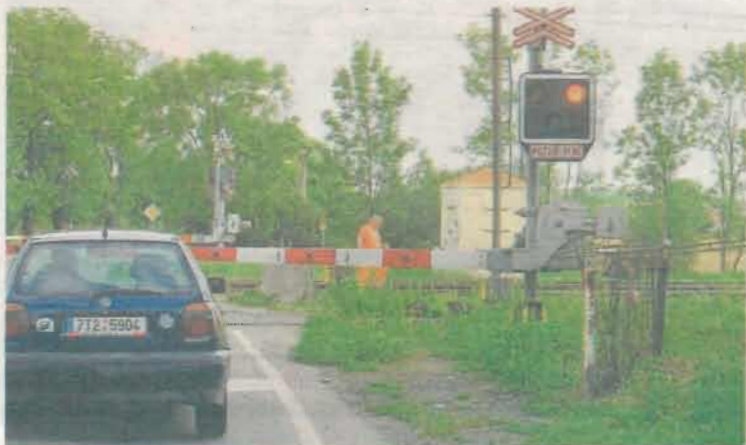
O MIMOÚROVŇOVÉM křížení silnice a železničního přejezdu ve Studénce se hovoří od roku 2018. Foto: Ivan Pavelek
