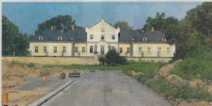
STAVBA SILNICE k zámku v Nové Horce, místní části Studénky.
