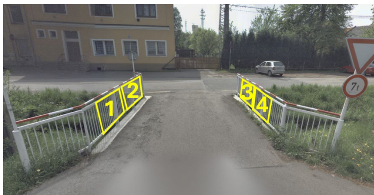
Oplocení mostku u zdravotního střediska mezi ulicemi Malá strana a Butovická
