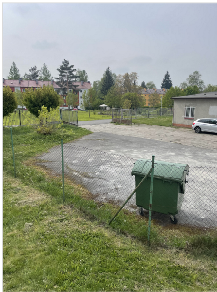
jižní vstupní a vjezdová brána
